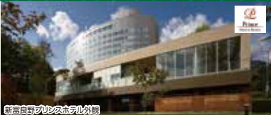
新富良野リゾートホテル外観
